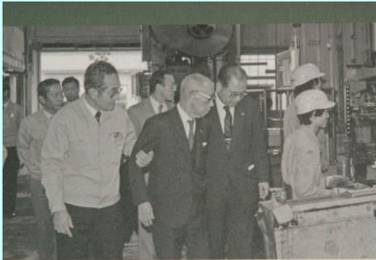
1980年(昭和55)創業者の手を引き、松下住設の工場内を案内する小川専務(当時)
