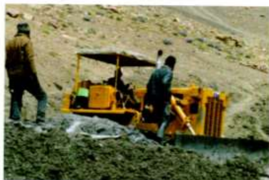
現在も工事中の道路(2023)
