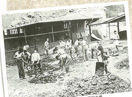
▲昭和13年の阪神風水害で被害を受けた校舎の復旧作業
